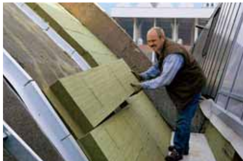
Einlegen der Shedrock Dämmplatte in das Z-Profil
