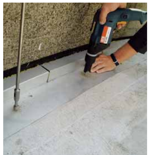
Befestigen des Z-Profils mit der Sonderbauschraube
