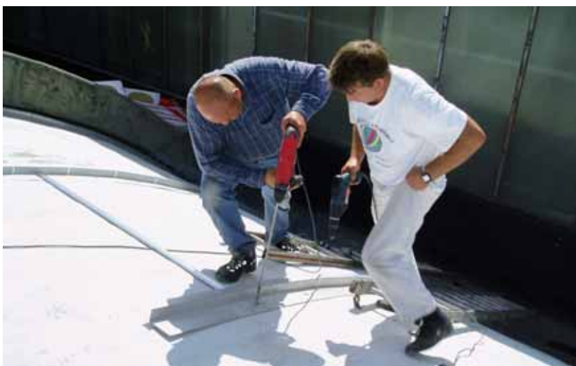
Vorbohren mit 5,0 mm Bohrdurchmesser
