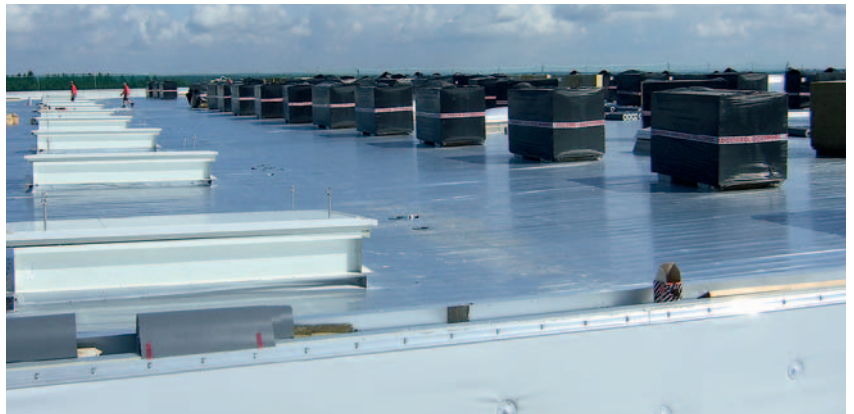
Durock 037 – besonders geeignet für Flachdächer mit mechanisch befestigtem Dachaufbau
