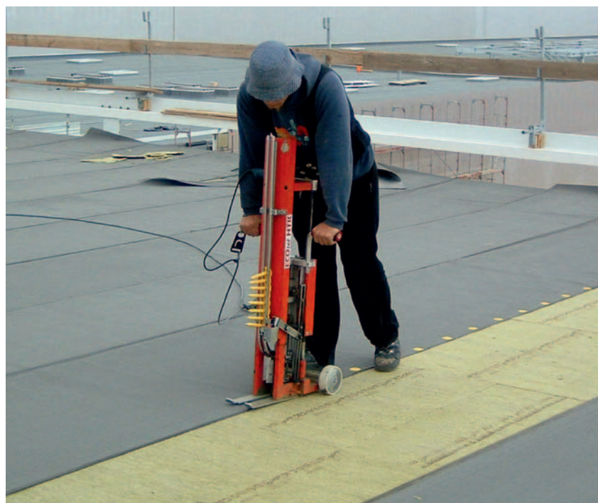
Mechanische Befestigung des Dachaufbaus mit Durock 037
