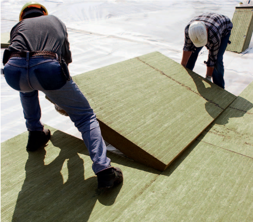
Verlegung der Durock 037
