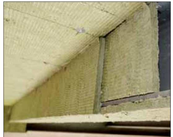
Stahlbau F30-A bis F180-A nach DIN 4102
