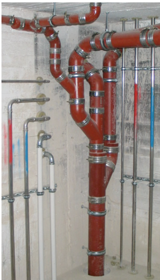
Typische Anwendung für Gebäudeentwässerung mit SML-Rohren
