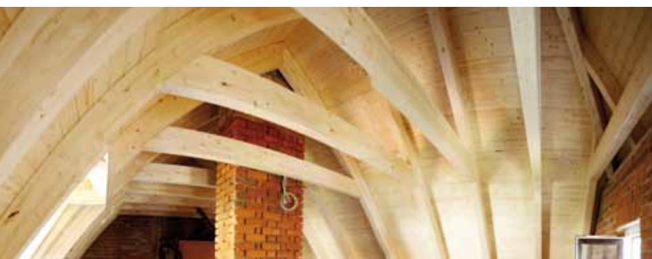
Der Charme der Zollinger Dachform wurde durch den von Zimmermeister Schuh konzipierten Dachstuhl perfekt rekonstruiert. Die auf der Innenseite lasierten Verschalungsbretter verbreiten gemeinsam mit den freigelegten Ziegelwänden eine mehr als wohnliche Atmosphäre. Dank der statischen Eigenschaften der Dachkonstruktion dienen selbst die Kehlbalcken nur ästhetischen und nicht unbedingt statischen Zwecken.
