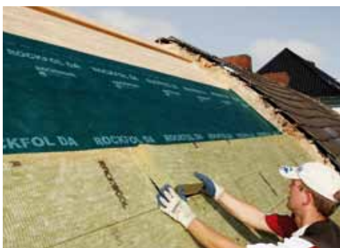
Leichter Zuschnitt, wenig Verschnitt dank der Rockwool Steinwolle-Dämmplatten im Sonderformat.
