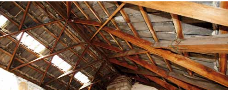
Das Zollingerdach des Schweizer Reihenhauses vor seiner Renovierung: stabil, aber weit davon entfernt, den Vorgaben der Energieeinsparverordnung im Falle von Dacherneuerungen zu entsprechen.
