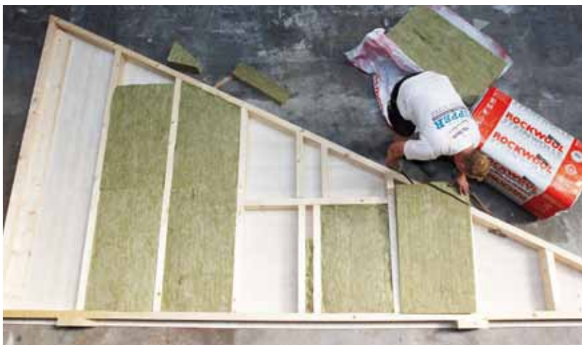
Moderne Holzbauweise ermöglicht Schall- und Wärmedämmung in einem.
