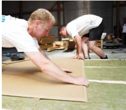
Beplankung der Außenwände.
