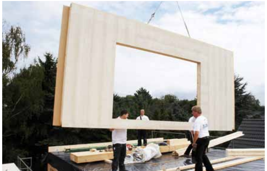
Die vorgefertigten Wandelemente wurden direkt auf die Baustelle geliefert und in einer Rekordzeit von drei Tagen vollständig montiert.
