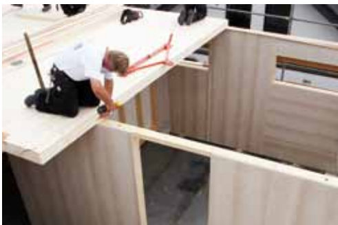
Einziehen der Zwischendecke.
