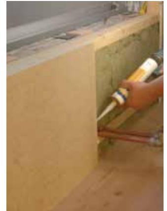
Verkleidung der Installationsebenen mit Gipsfaserplatten.
