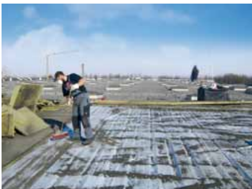
Nach der Demontage wurden die Trapezprofile gesäubert.
