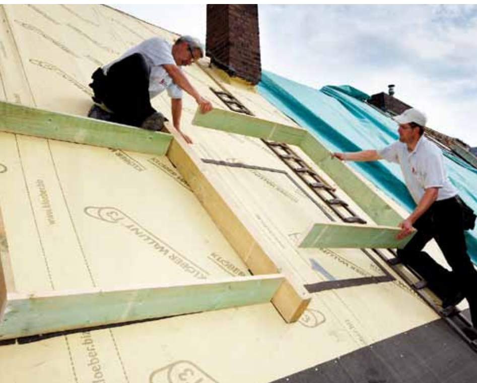
Zuvor exakt angepasste Holzrahmen bildeten die „Vorhut“ für die speziellen Schallschutzfenster.
