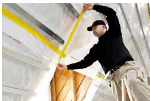
Mit dem Klebeband „Rockfol KB 1“ und dem dauerelastischen Dichtkleber „Rockfol DK“ von Rockwool konnte die Dachkonstruktion luftdicht abgeschlossen werden.
