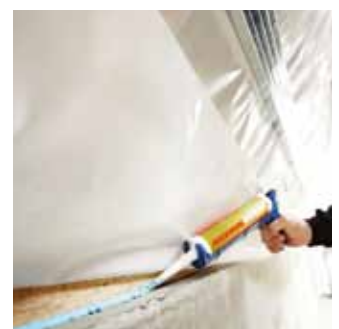
Mit dem Klebeband „Rockfol KB 1“ und dem dauerelastischen Dichtkleber „Rockfol DK“ von Rockwool konnte die Dachkonstruktion luftdicht abgeschlossen werden.
