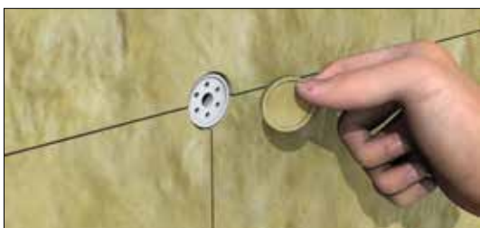
Junta em T: Coloca-se uma espiga no centro de cada painel e em cada ponto de contacto de junta horizontal com junta vertical
